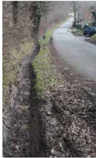
Mars 2018 : les égouts sont remis à niveau avenue de la Forêt et les fossés sont curés rue du Gart et rue de la Chapelle permettant un meilleur écoulement des eaux pluviales ▼
