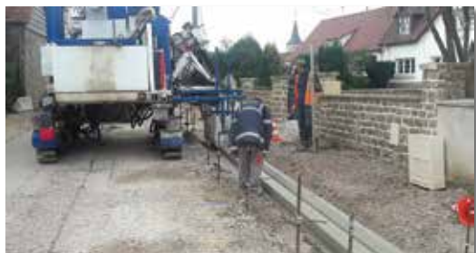
Octobre 2018 : Coulage des bordures.
