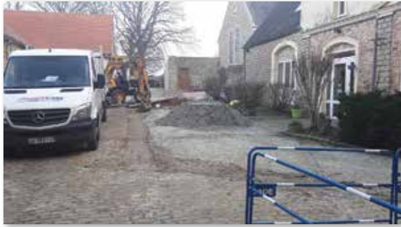
Février 2018 : mise aux normes de l'assainissement de la Médiathèque et des locaux communaux (ancien presbytère)
