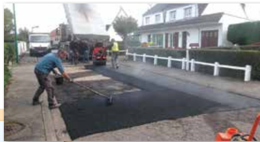
La commune rénove la chaussée de la résidence Huplandre pour le confort des riverains ▲
