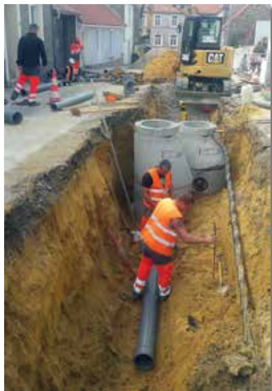
Août 2018 : Création du réseau collectif eaux pluviales et eaux usées
