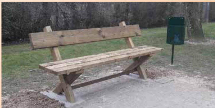
Février 2018 : Les employés communaux ont remplacé trois bancs
